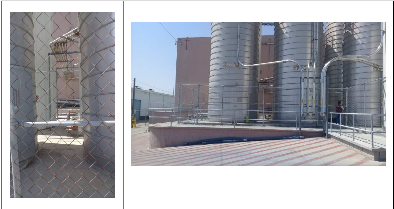
Figura 8. Manejo de resinas en una planta de inyección de plásticos, debido a la demanda la resina es surtida por camiones y almacenada en silos conteniendo un tipo de ellas sin mezclarse. Luego son distribuidas por un sistema de succión hacia el interior de la planta de producción.
