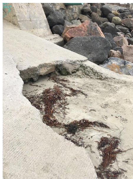
Figura 34 Accesos de playa. En a) rampa de acceso peatonal en calle palmas. En b) rampa para personas discapacitadas, en c) zona de vista a playa, en d) parte inferior de rampa de acceso en calle palma
