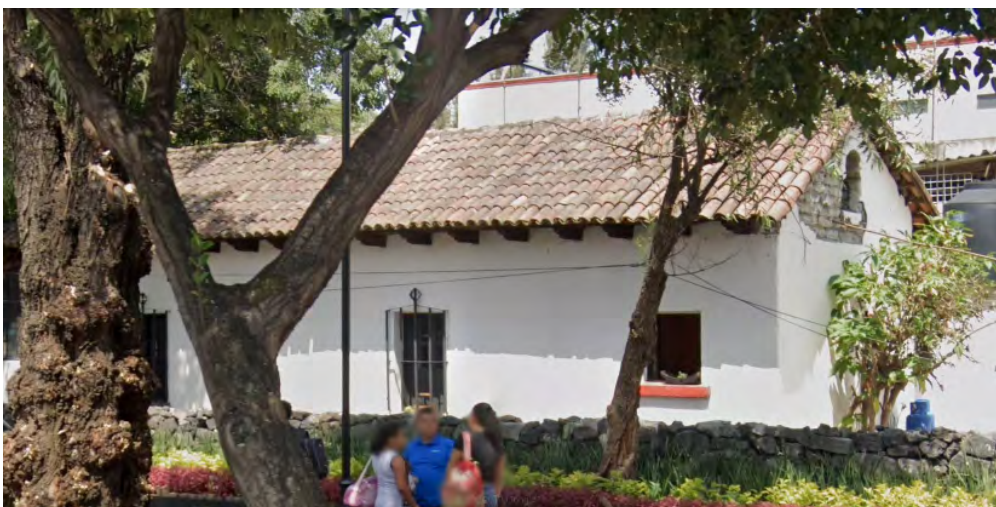
Figura 7. Vivienda con muros de adobe y cubierta inclinada, a dos aguas, con tejas de barro, ubicada en la esquina de Av. Guadalupe I. Ramírez y Francisco Goitia
